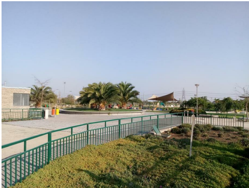
Fotografía 9. Parque Pierre Dubois, desarrollado en una zona de riesgo de derrumbe, actualmente desafectado por la restricción del PRMS.
